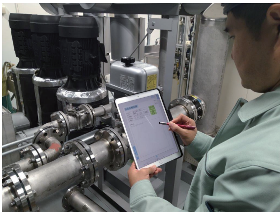
그림2 태블릿을 이용한 유지 보수 작업
